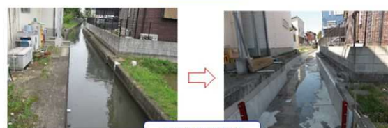
開水路の表面被覆補修
