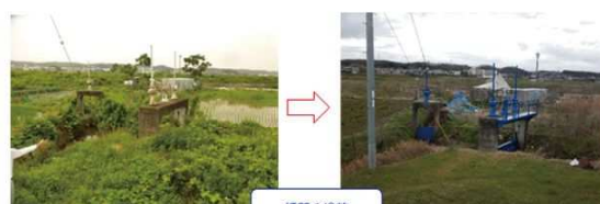
ゲートの塗装
