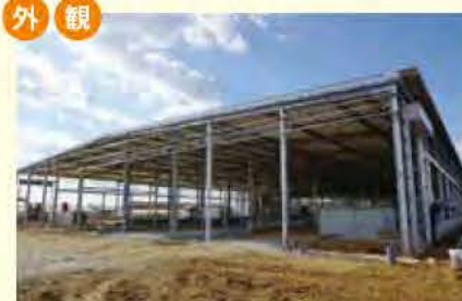
建設中の新牛舎
